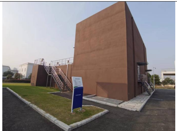
反硝化深床滤池
