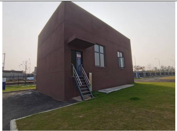
二次提升泵房
