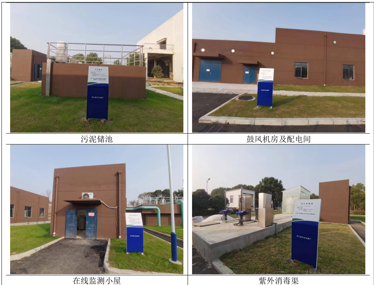
图 3-4 厂区主要建筑物照片
