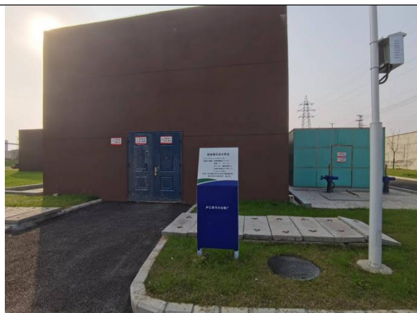
粗栅格及进水泵房
