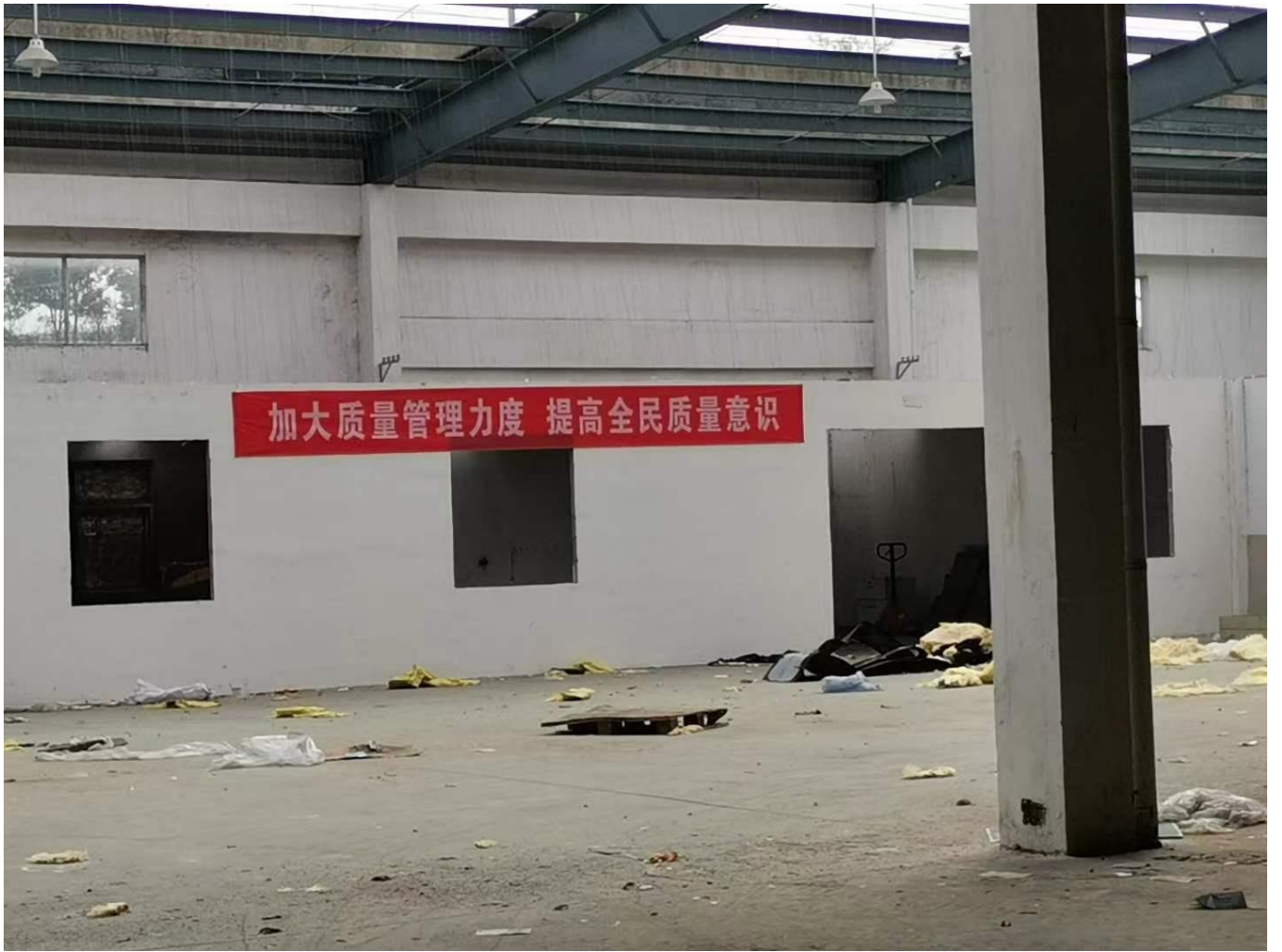
先期项目原厂区搬迁后现场
