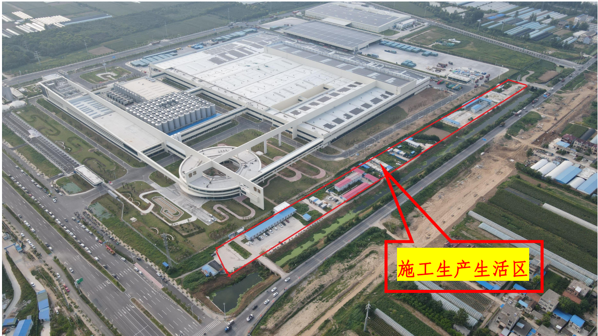
图 1-2 施工生产生活区
