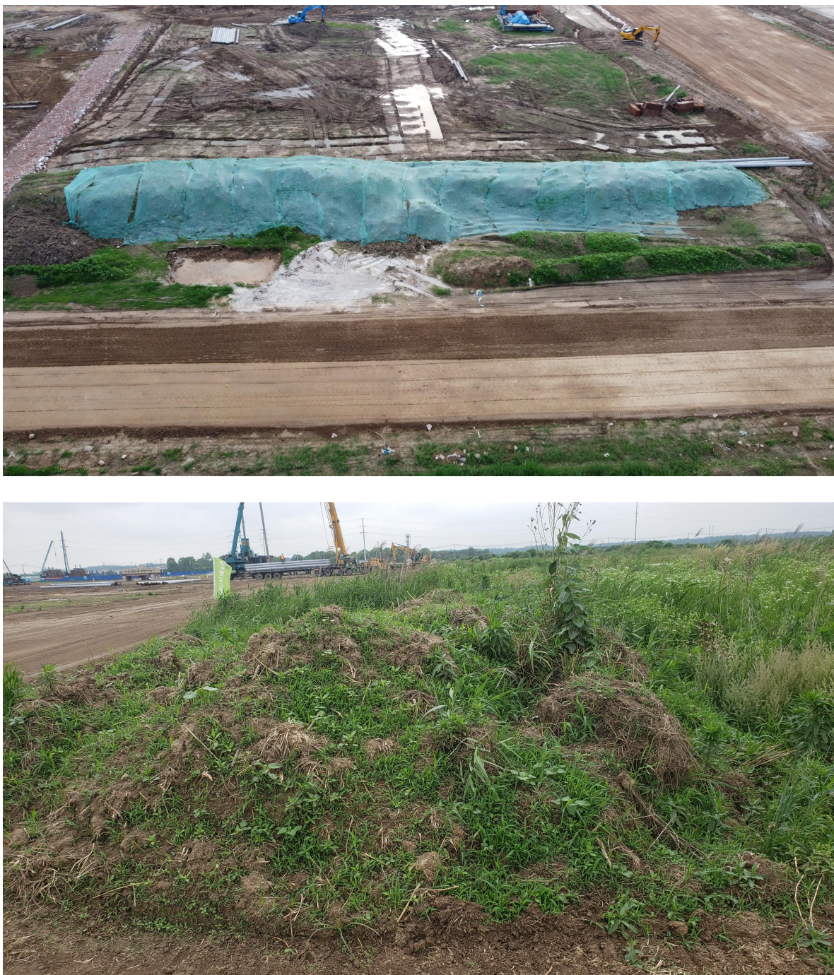
图 1-3 临时堆土情况
