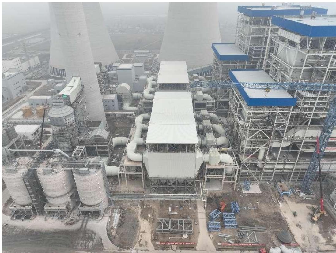
图 4-2 静电除尘器
