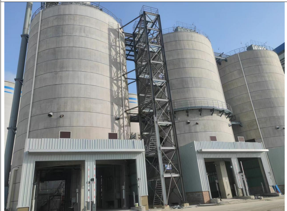
灰库（顶部设布袋除尘器）
