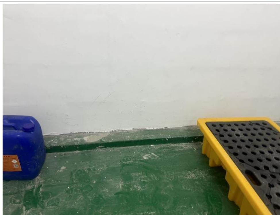
防漏托盘+导流槽
