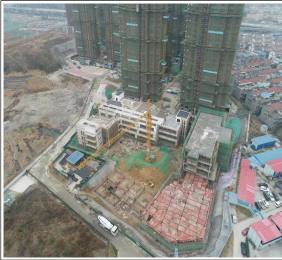
主体工程监测过程照片
