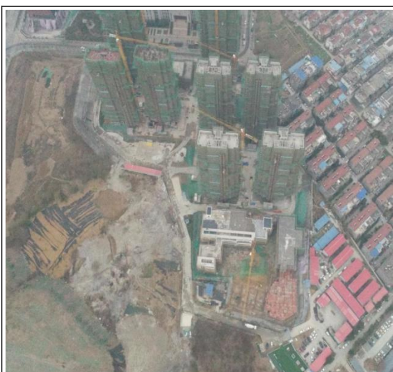
主体工程监测过程照片
