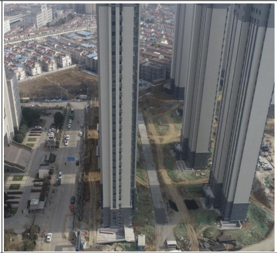
主体工程监测过程照片
