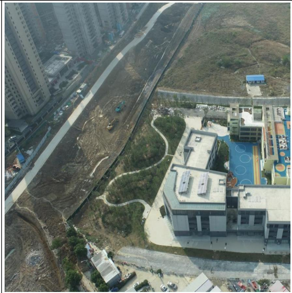
临时堆土区现状
