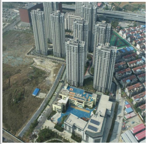
主体工程区现状
