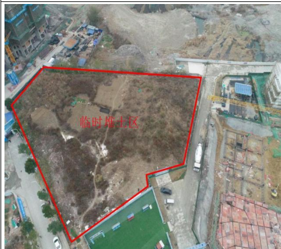
临时堆土区监测过程照片
