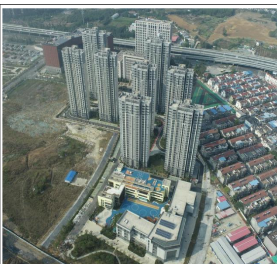
主体工程现状
