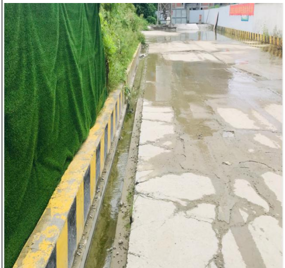
临时排水沟监测过程照片
