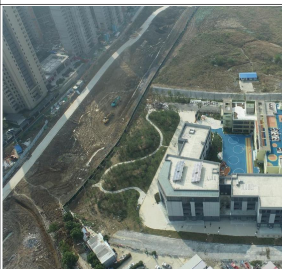
临时堆土区现状
