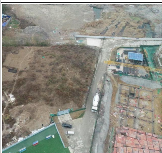
临时堆土区监测过程照片
