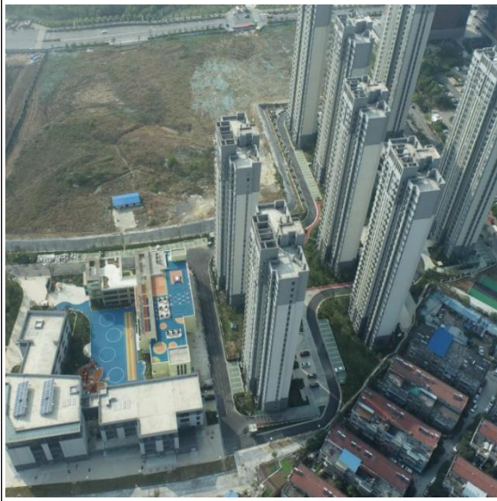
主体工程区现状
