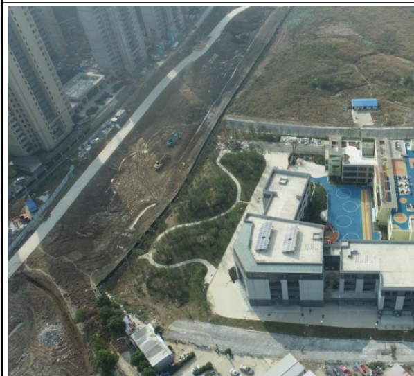
临时堆土现状
