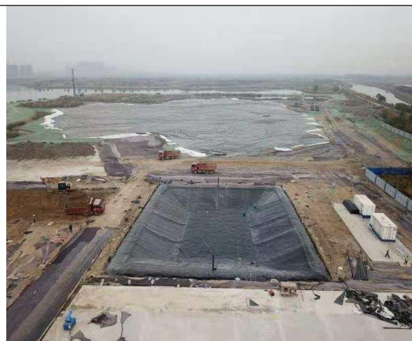
项目区施工过程照片 1
