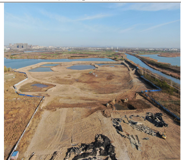
项目区施工过程照片 5
