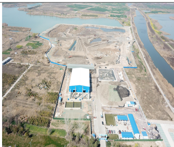
项目区施工过程照片 2
