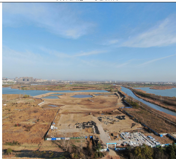
项目区施工过程照片 6
