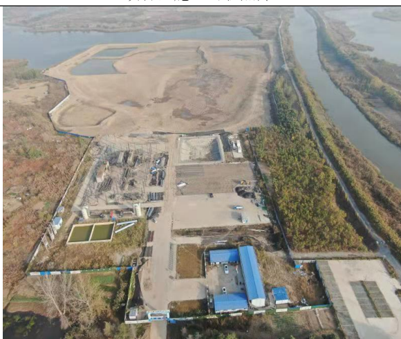
项目区施工过程照片 4
