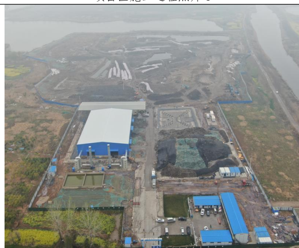
项目区施工过程照片 3
