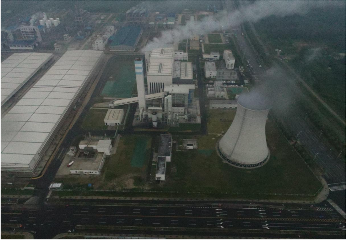
厂区航拍图（2019年7月）
