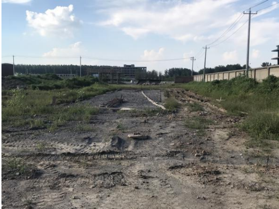
北侧进厂道路（2018年6月）
