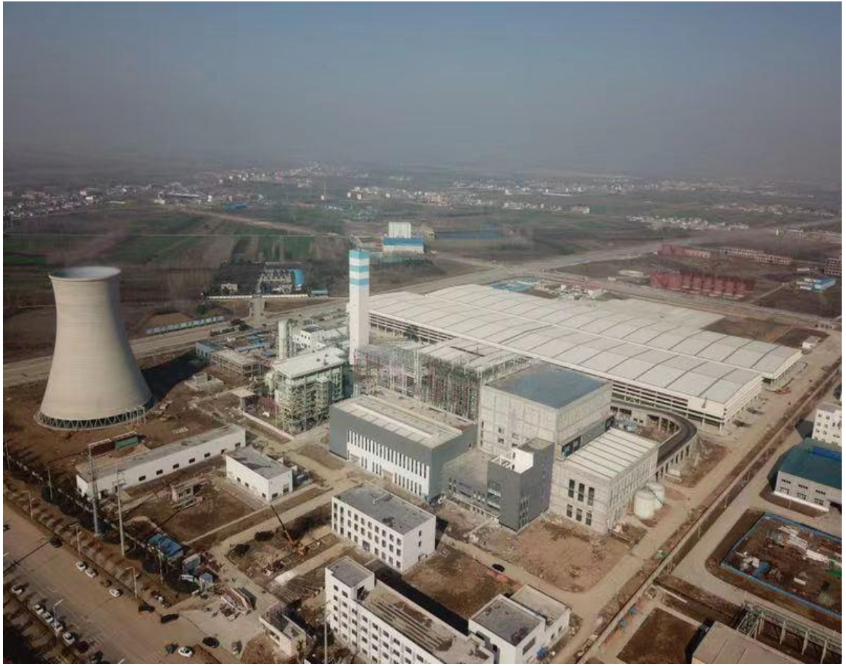
厂区航拍图（2018年11月）
