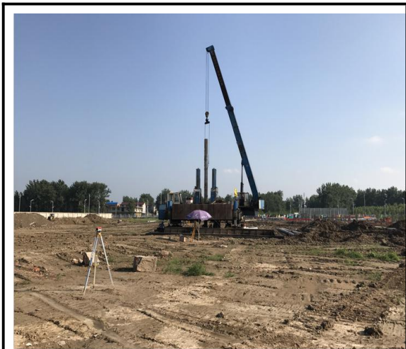
厂区桩基施工
