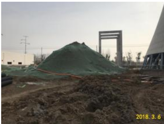
3#监测点（冷却塔区域）
