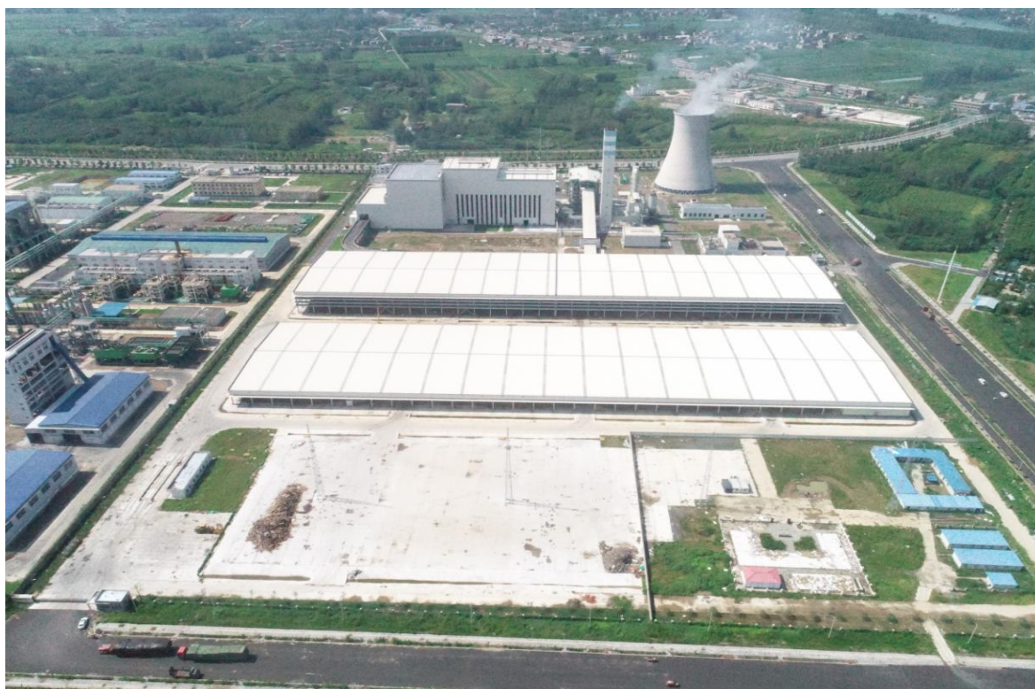
厂区航拍图（2019年5月）
