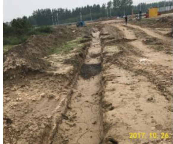
施工场地区域临时土质排水沟
