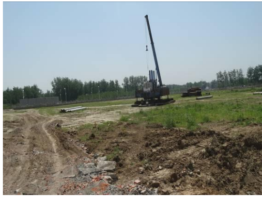
厂区桩基施工
