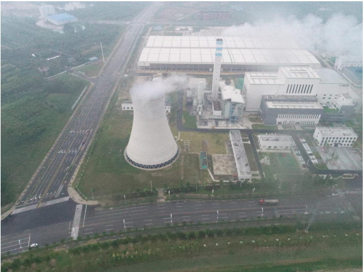
厂区航拍图（2019年7月）
