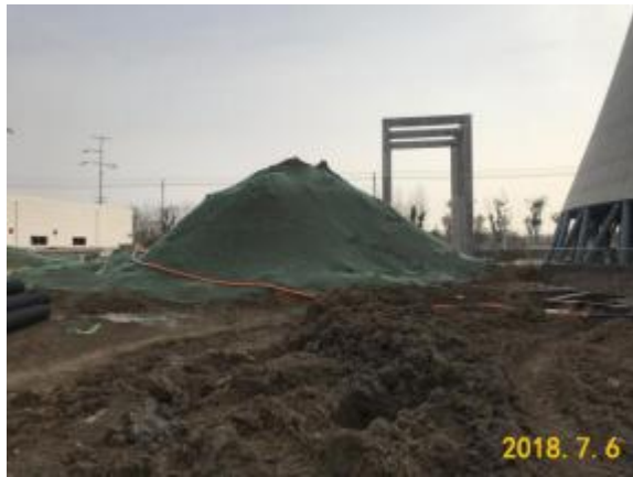
临时堆土覆盖
