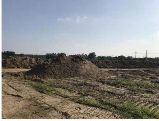
厂区表土剥离
