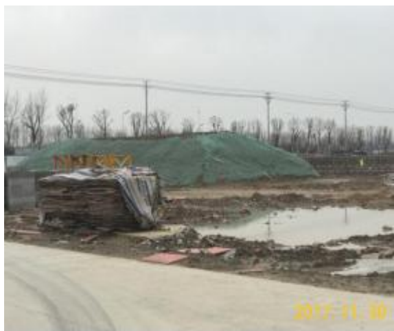
1#监测点 (剥离表土堆放区)
