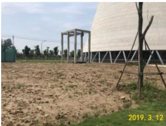
冷却塔区域土地整治、表土回覆
