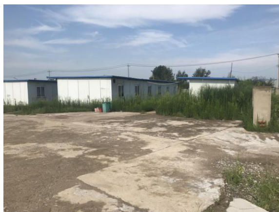
施工管理生活区现状
