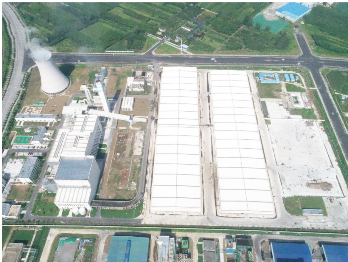
厂区航拍图（2019年5月）
