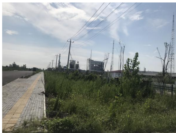
北侧厂界外现状
