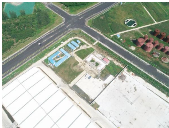
施工管理生活区航拍图
