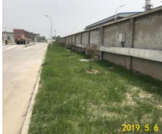
环形道路两侧土地整治后
