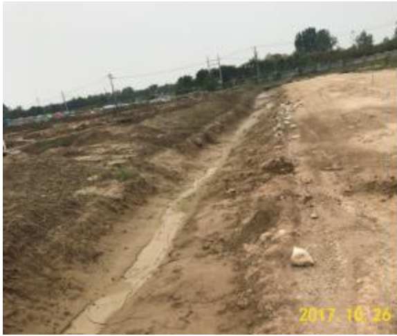
施工场地区域临时土质排水沟
