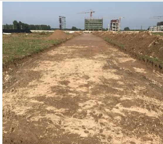
厂区环形道路基础开挖
