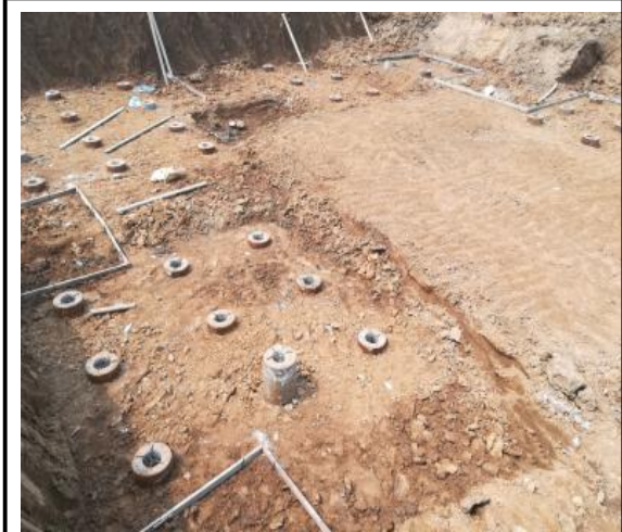
主厂房二区土方开挖
