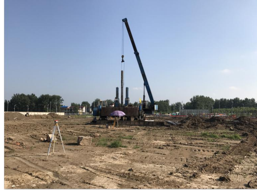
厂区桩基施工
