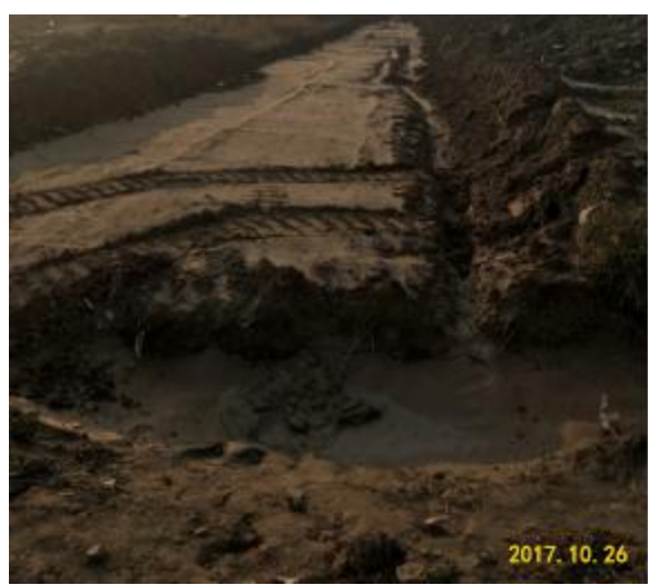
临时土质沉淀池
