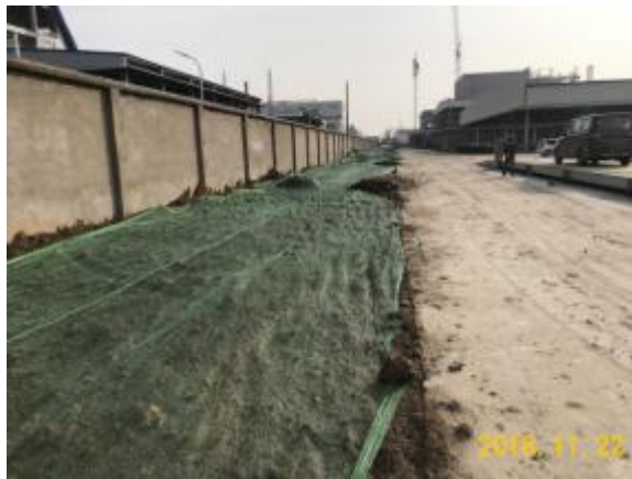
道路周围裸露区域苫盖
