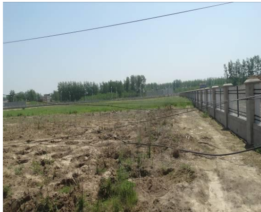
厂区围墙（西侧）
