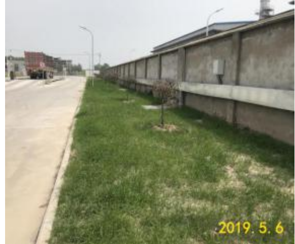
厂区东侧围墙内侧 (2019年5月)
