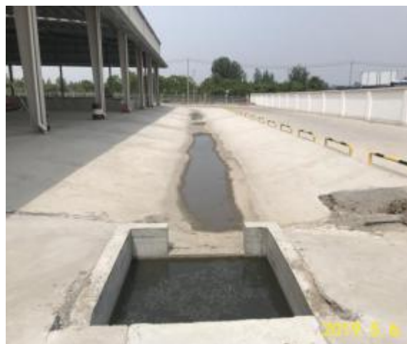
V 型排水沟及沉砂池
