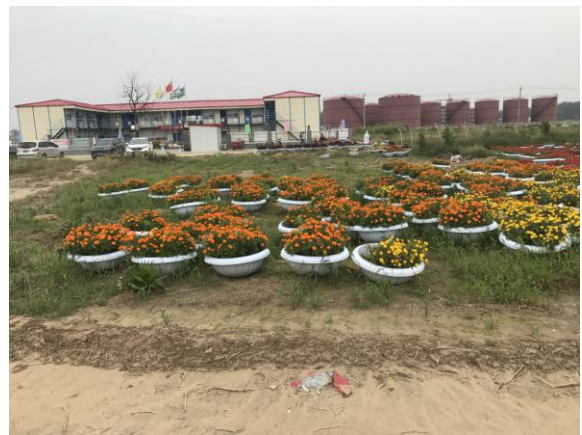
施工管理区（2017年9月）
