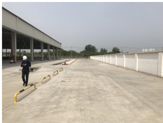
场内环形道路
