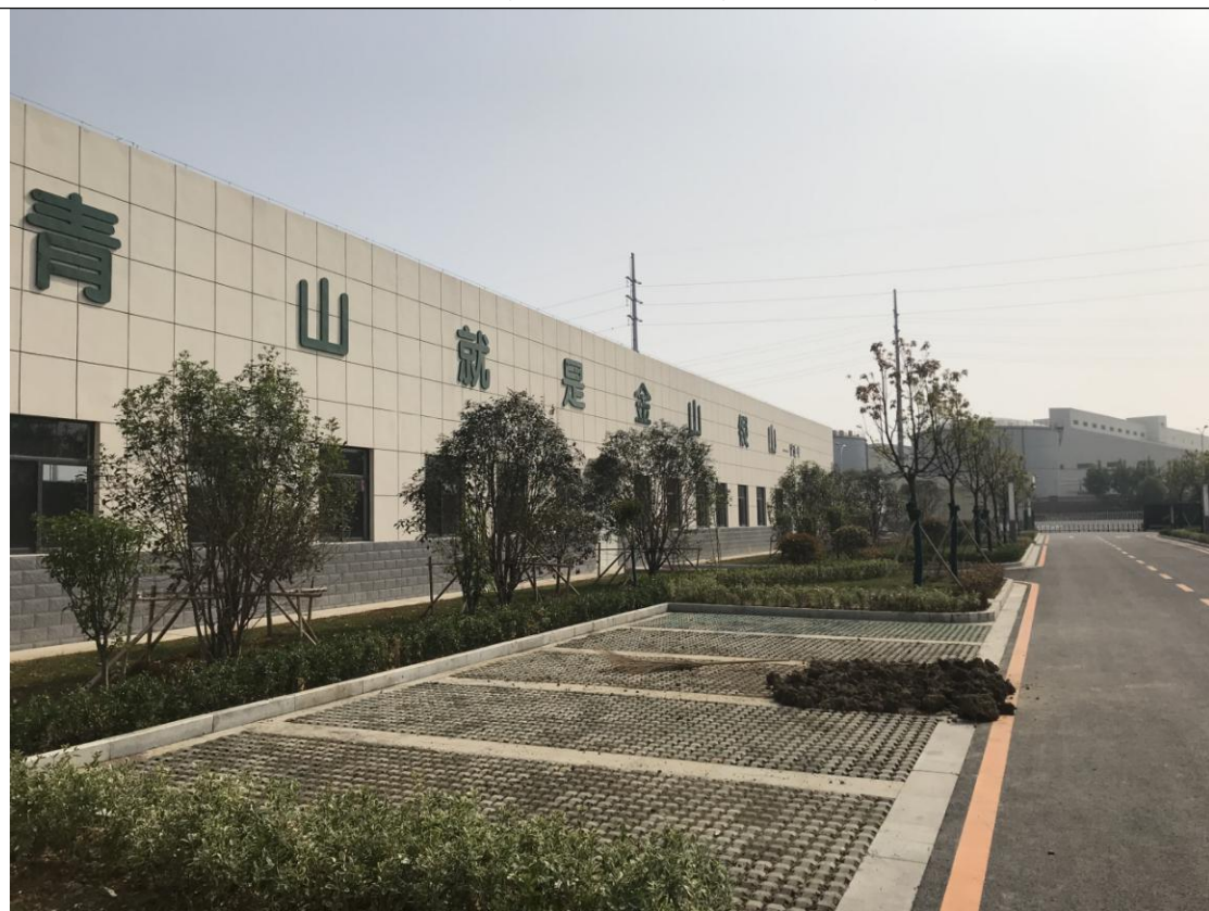
凤阳光大项目：无裸露区域，按需硬化，剩余部分全部绿化，草灌结合，停车场敷设透水砖
