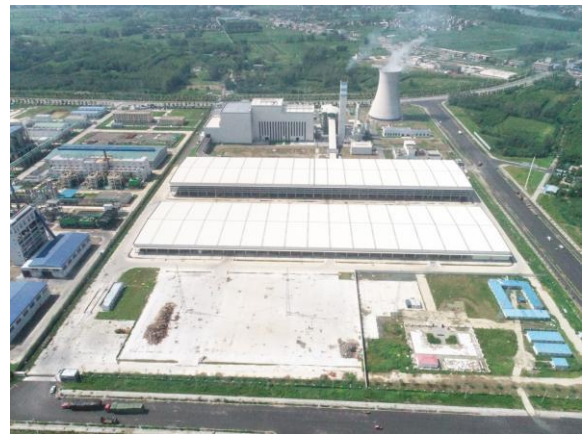
厂区现状航拍图
