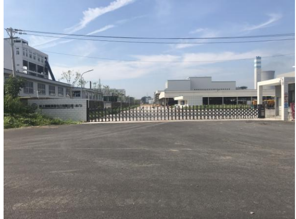
北侧进厂道路（2019年7月）
