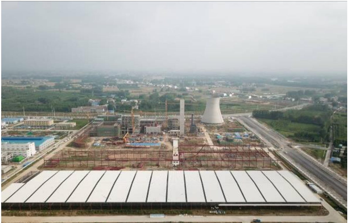
厂区航拍图（2018年11月）
