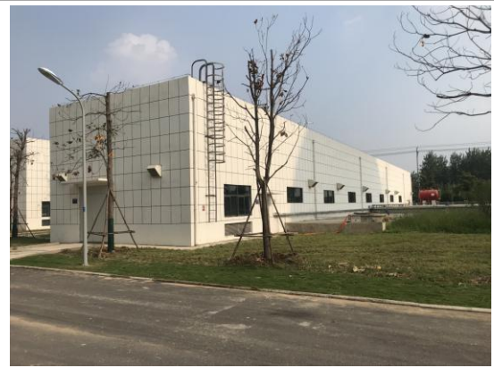
综合和水泵房
