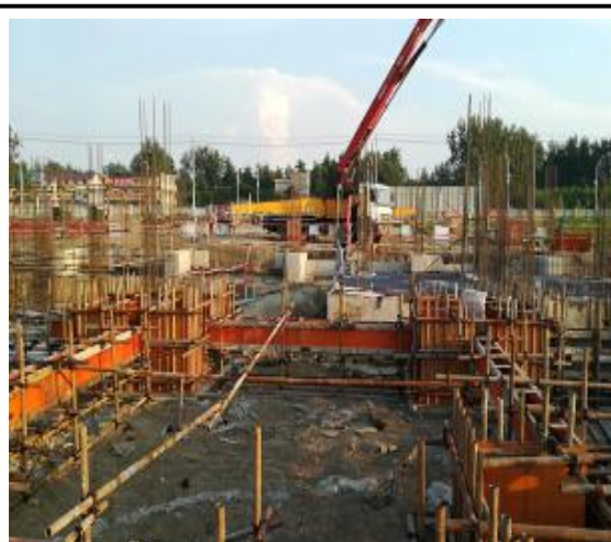
主厂房基础混凝土浇筑
