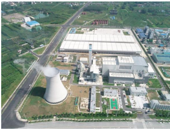
厂区现状航拍图
