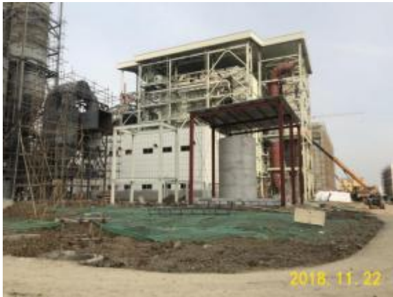
生产区域土地整治、表土回覆
