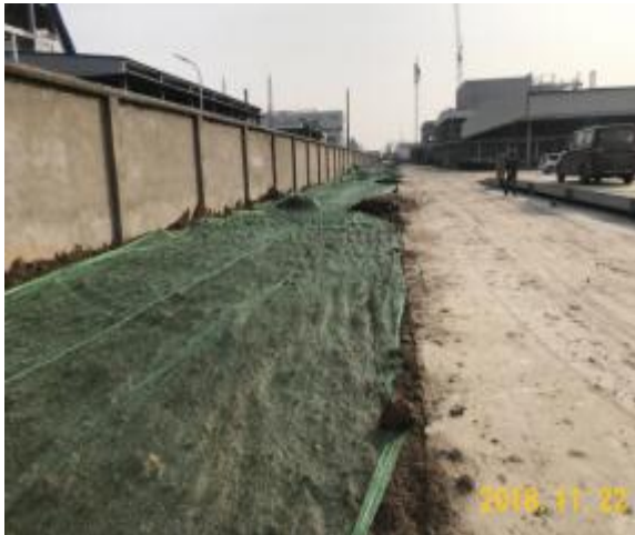
厂区东侧围墙内侧 (2018年11月)
