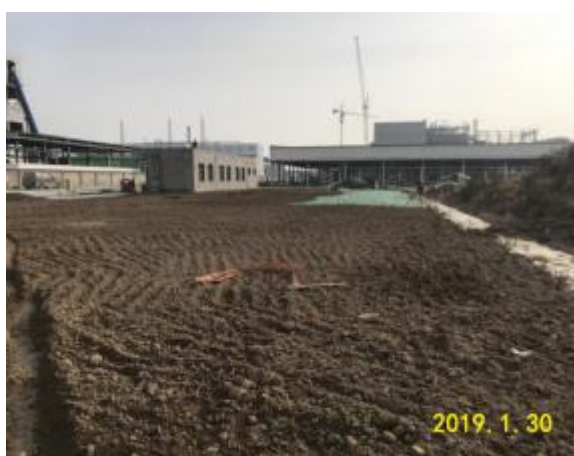
地磅房区域土地整治，表土回覆
