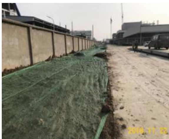
环形道路两侧土地整治，表土回覆
