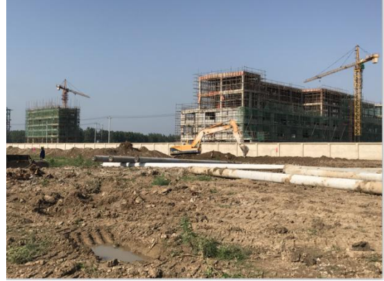
厂区围墙（东侧）
